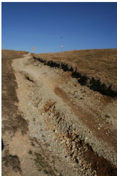
Fig. 1-3 - Nei solchi scavati dalle ruote delle moto l'acqua scorre con maggior velocità trascinando materiale solido e determinando un'azione erosiva che approfondisce e allarga i solchi fino a rendere il transito dei mezzi di servizio a quattro ruote di impossibile e anche fino a mettere a nudo la roccia sottostante
