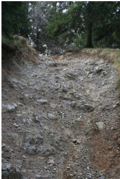
Fig. 1-3 - Nei solchi scavati dalle ruote delle moto l'acqua scorre con maggior velocità trascinando materiale solido e determinando un'azione erosiva che approfondisce e allarga i solchi fino a rendere il transito dei mezzi di servizio a quattro ruote di impossibile e anche fino a mettere a nudo la roccia sottostante
