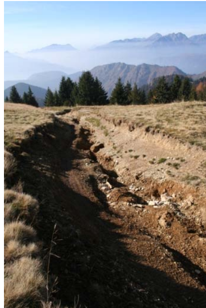
Fig. 1-3 - Nei solchi scavati dalle ruote delle moto l'acqua scorre con maggior velocità trascinando materiale solido e determinando un'azione erosiva che approfondisce e allarga i solchi fino a rendere il transito dei mezzi di servizio a quattro ruote di impossibile e anche fino a mettere a nudo la roccia sottostante
