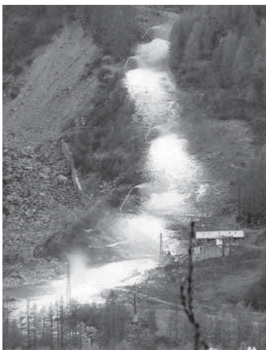
Foto 1. Impianto di innevamento ad alta pressione: Macugnaga 19/11/2005 www.funivie.org
