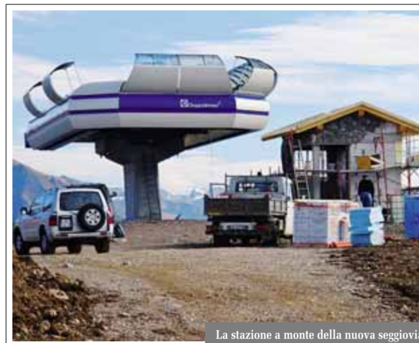
La stazione a monte della nuova seggiovia
