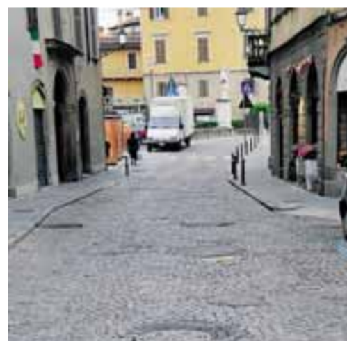
La parte più vecchia di via Borgo Palazzo coperta con il porfido è completamente dissestata. In alcuni punti, gli avvallamenti sono stati coperti con gettate di asfalto: il risultato è una strada rappazzata che crea problemi agli automobilisti ma soprattutto ai residenti. Il comitato locale si è incontrato per sollecitare il Comune a intervenire per restituire alla via la dignità richiesta dal borgo (foto Bedolis)
