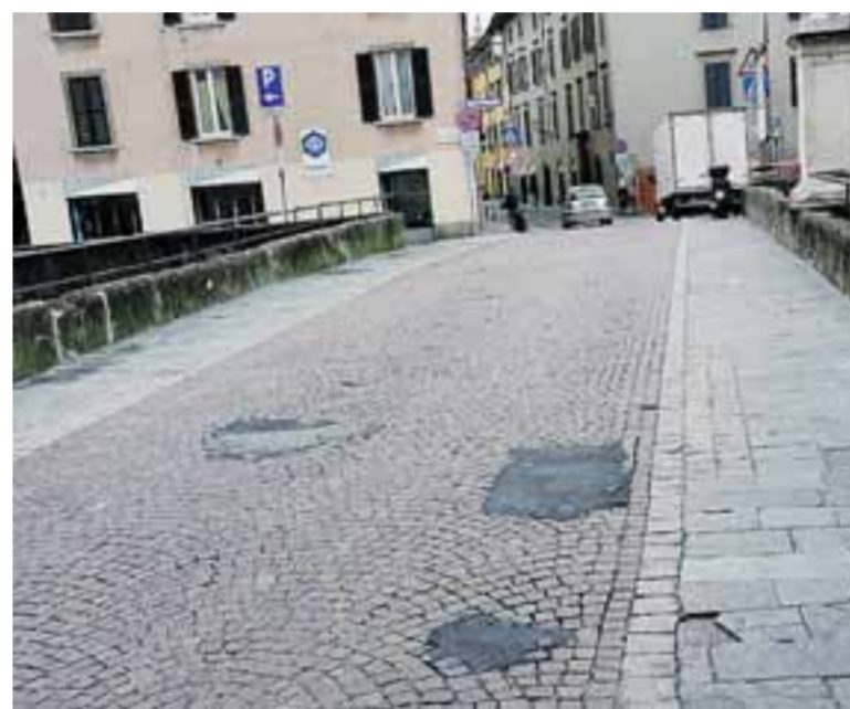
La parte più vecchia di via Borgo Palazzo coperta con il porfido è completamente dissestata. In alcuni punti, gli avvallamenti sono stati coperti con gettate di asfalto: il risultato è una strada rappazzata che crea problemi agli automobilisti ma soprattutto ai residenti. Il comitato locale si è incontrato per sollecitare il Comune a intervenire per restituire alla via la dignità richiesta dal borgo (foto Bedolis)
