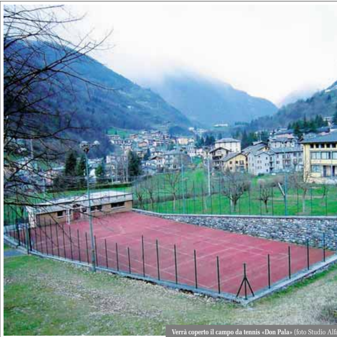
Verrà coperto il campo da tennis «Don Pala» (foto Studio Alfa)
