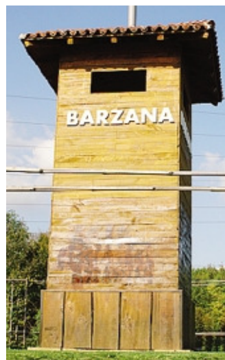
La torretta imbrattata dai vandali
