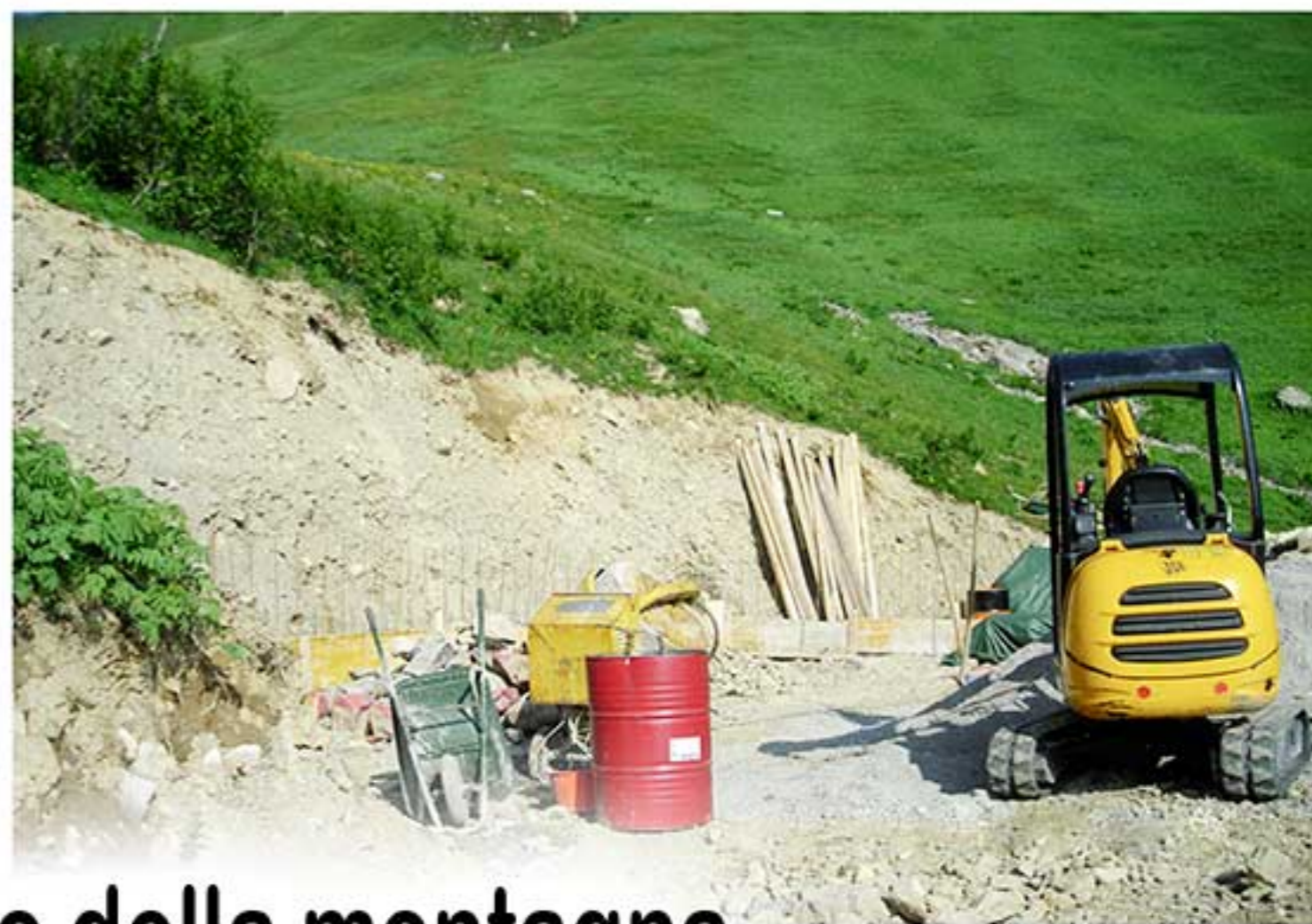
Costruzione del rifugio presso il Branchino
