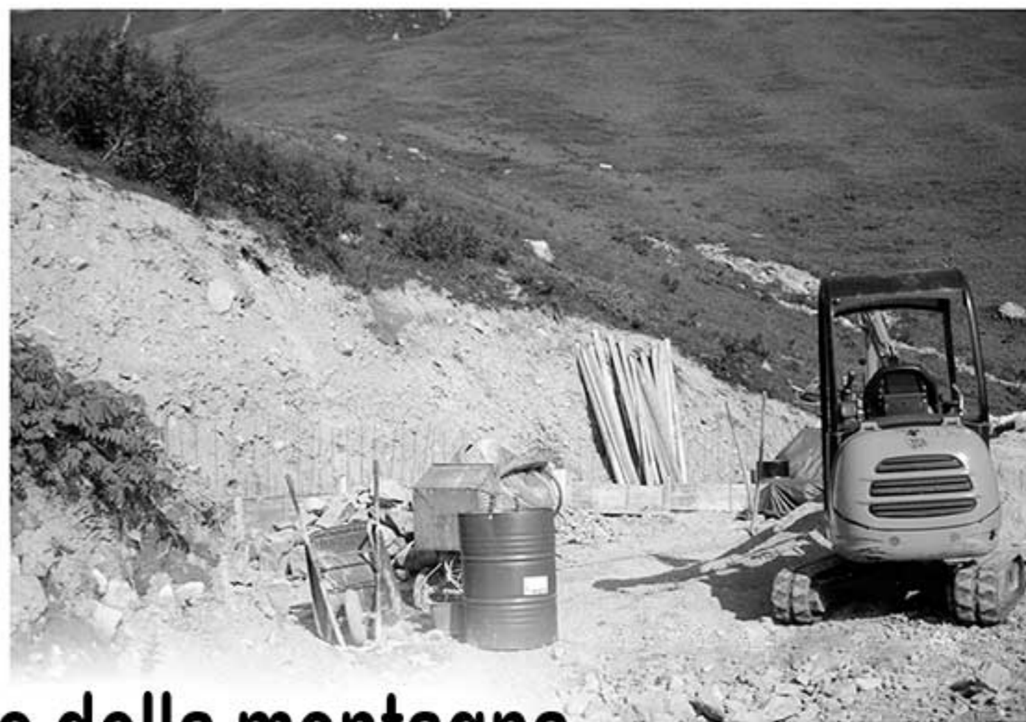
Costruzione del rifugio presso il Branchino
