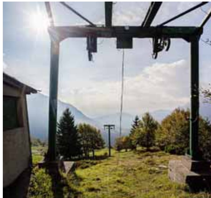
Il punto di arrivo dello skilift sull'Arera, intorno a 2.000 metri di quota
